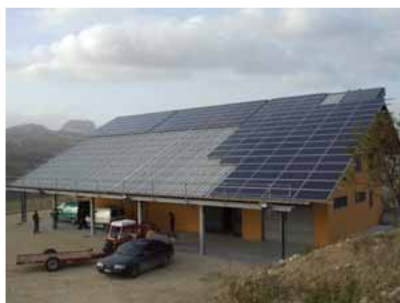
L'impianto fotovoltaico in fase di realizzazione.
