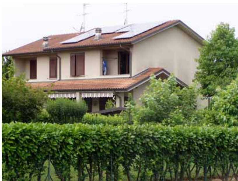
Impianto da 3 kWp installato a Bernareggio (MI) – 07/2005
