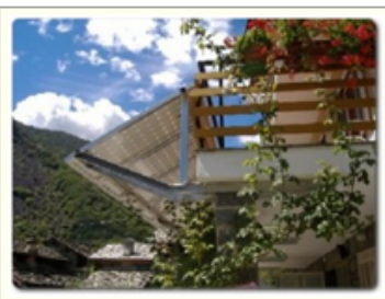
impianto realizzato a Torino
