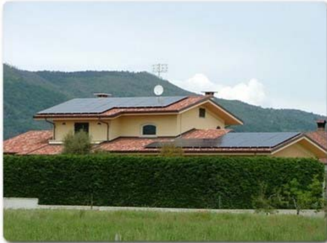
Impianti su edifici
